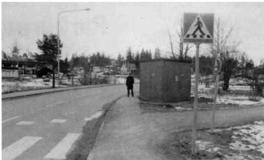
Transformatorn vid Snättringeleden mitt emot Vivobutiken skymmer sikten för både fotgängare, bussar och bilar.
