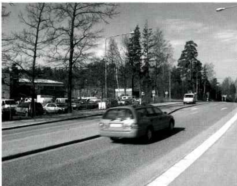
I korsningen Utsäljeleden och Häradsvägen planeras för ett nytt lågprisvaruhus. Blir det verklighet kommer också en ny rondell att byggas
