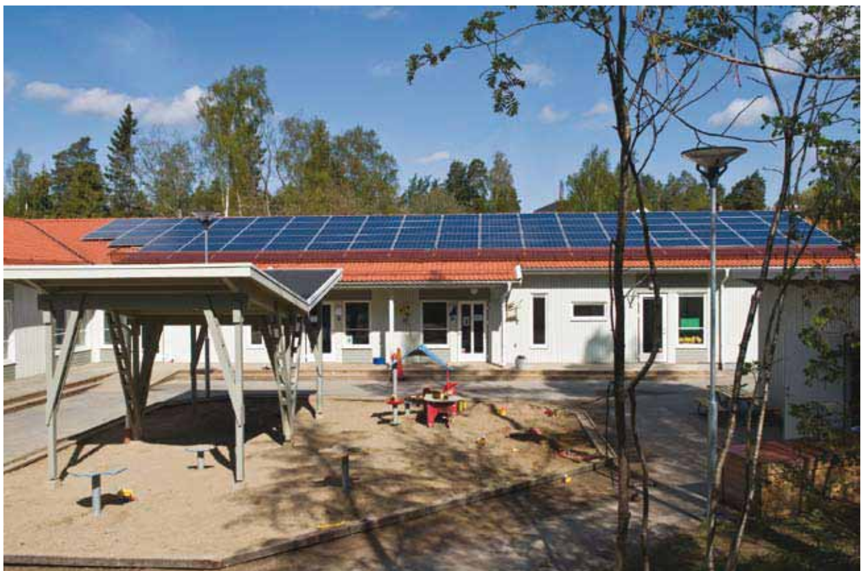
Furuhöjdens förskola i Fullersta är en av de kommunala anläggningar som testar att få el från solenergi.
